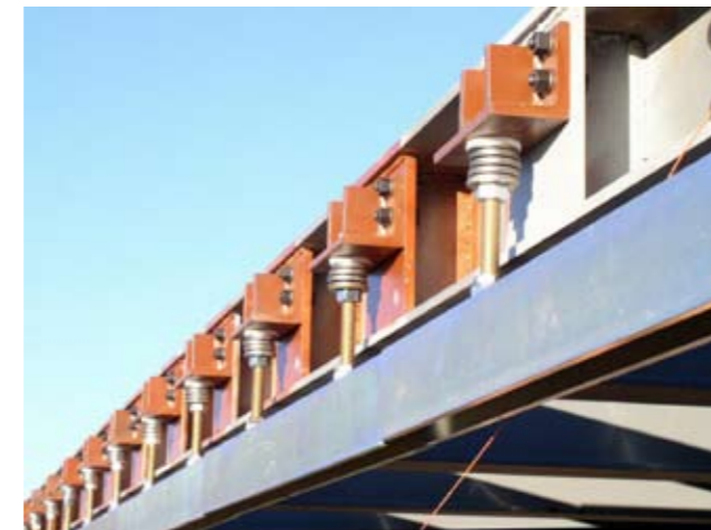
图例12 铁槽结构 Figure 12 Top Shoe Detail
