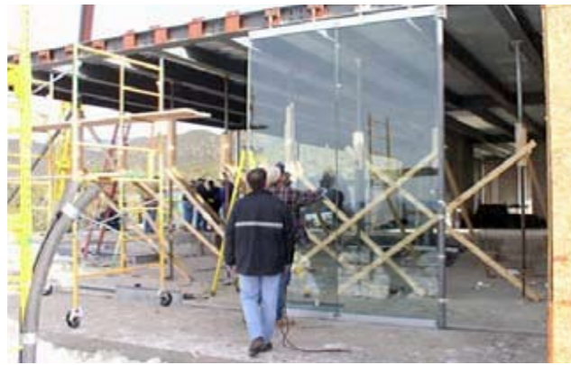
图例13 安装玻璃板 Figure 13 Panel Installation
